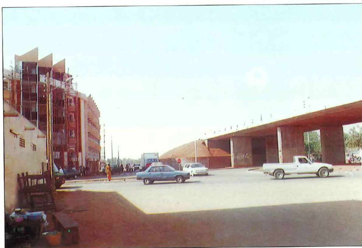
Nouvel échangeur de Bamako, chantier du Complexe Babemba - République du Mali.
