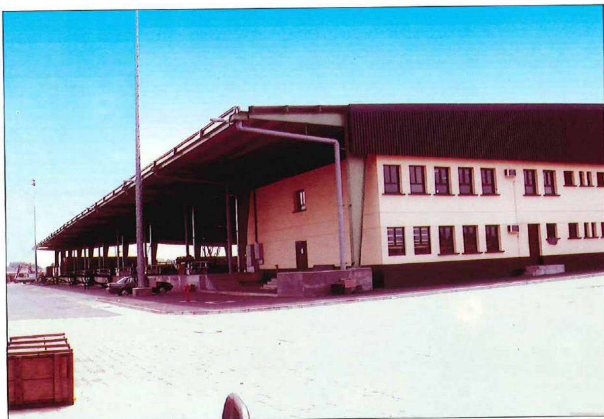
Quai bananier au Port Autonome d'Abidjan - République de Côte d'Ivoire.
