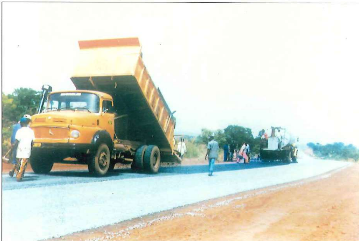
Travaux de bitumage de la route Bobo-Dioulasso - Orodara (Frontière du Mali) - Burkina Faso.
