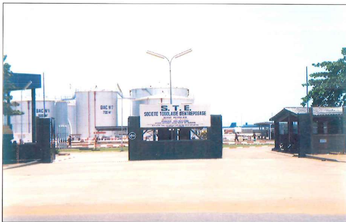
Installations de la Société Togolaise d'Entreposage (S.T.E.), zone portuaire de Lomé - République togolaise.
