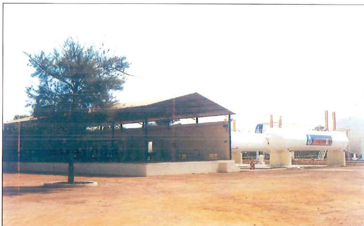
Installations de la Société PETROGAZ - République de Guinée-Bissau.
