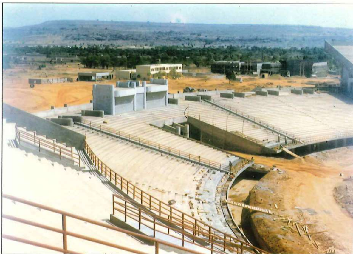
Chantier du Stade du 26 Mars à Bamako - République du Mali.
