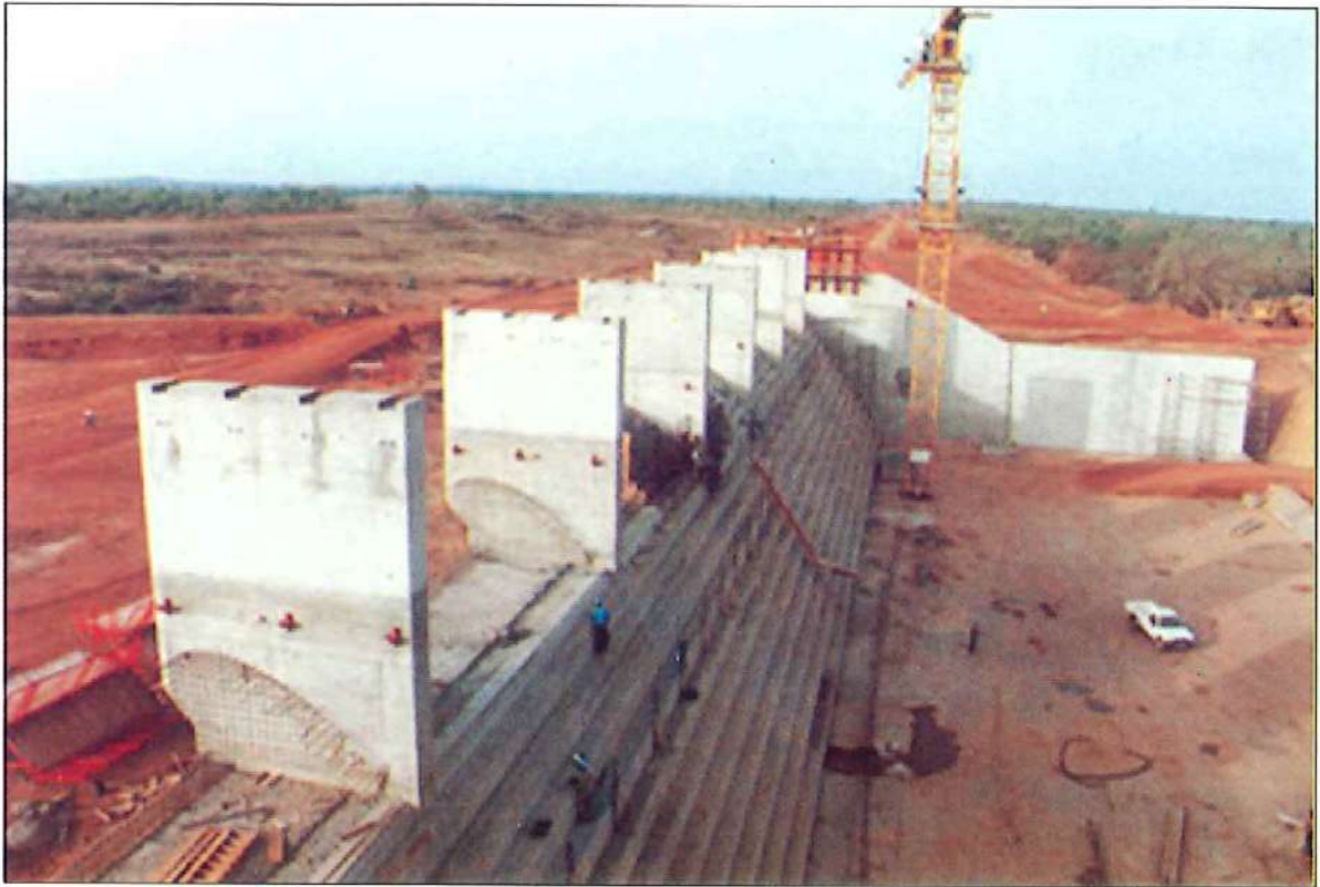
Chantier de construction du barrage de Ziga, vue aval du déversoir et des piles du pont - Burkina Faso.
