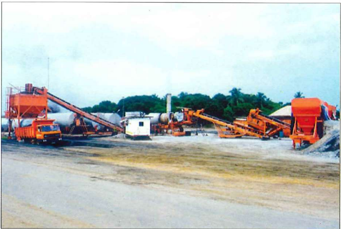
Travaux de construction de la route Cotonou (Bénin)-Lomé (Togo) - République du Bénin.
