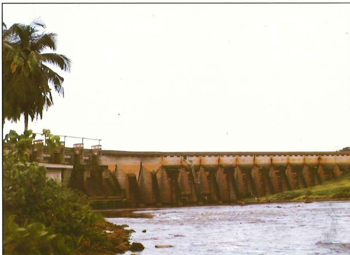
Barrage hydroélectrique d'Ayamé (R. de Côte d'Ivoire)
