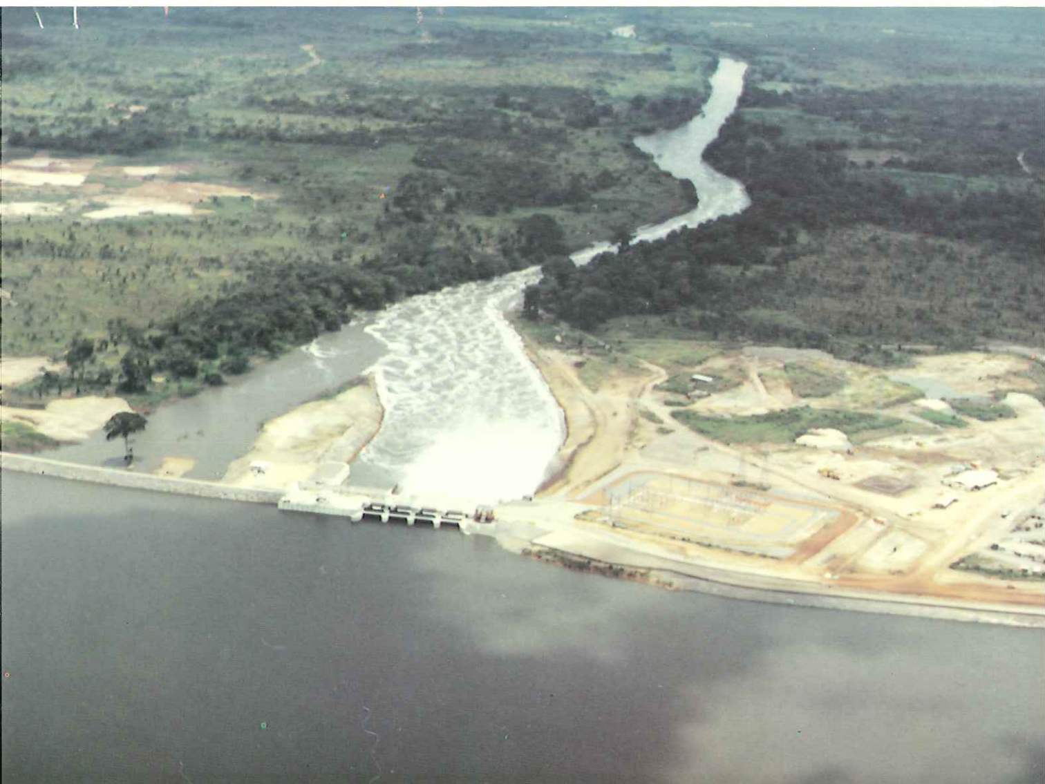
Barrage de NANGBETO (Togo).
