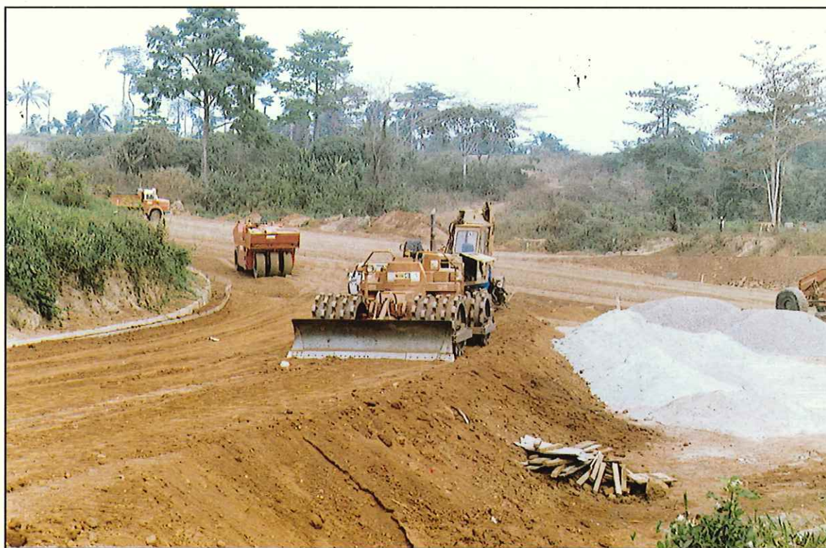
Construction de routes : Autoroute du Nord / Agboville - République de Côte d'Ivoire.
