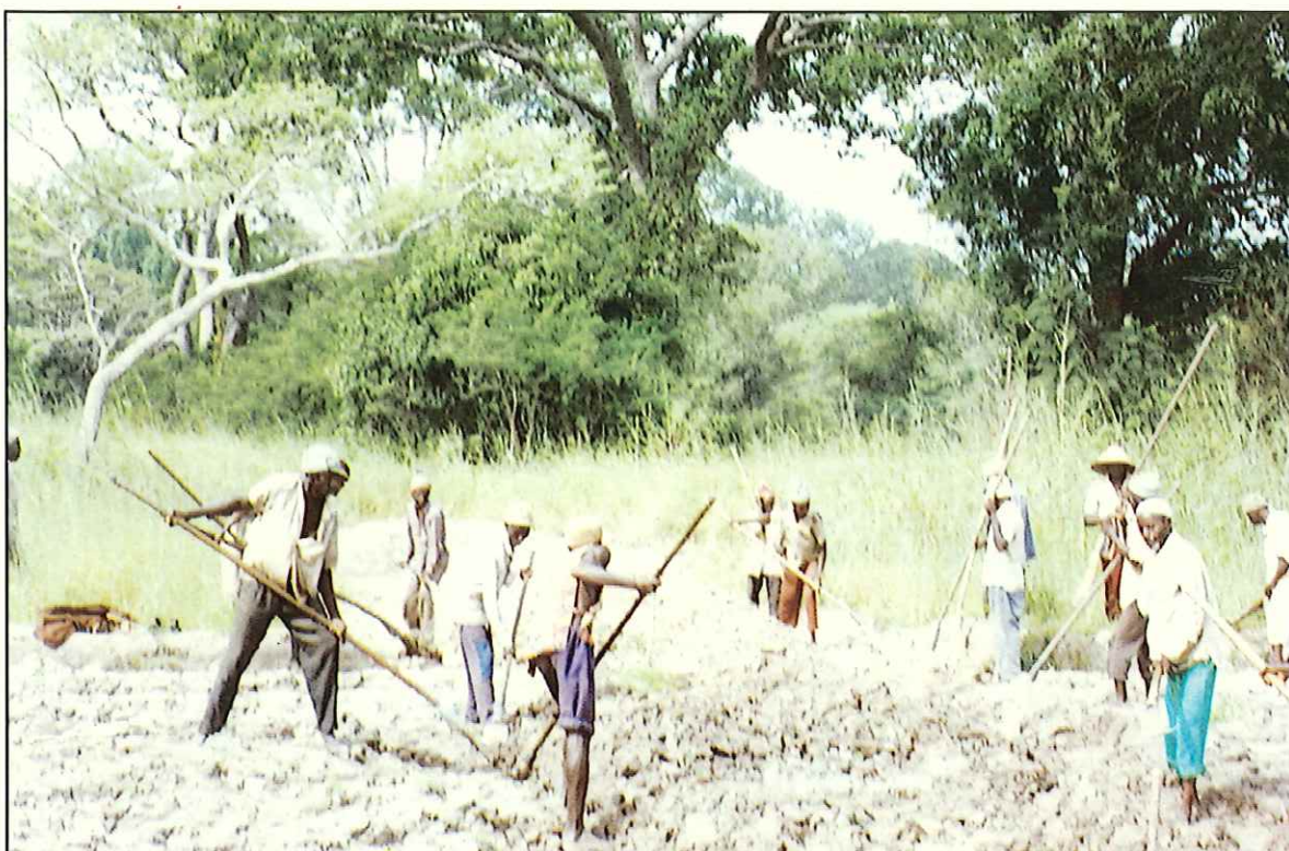
Travaux d'entretien d'une diguette à l'outil traditionnel (kadjandou) - République du Sénégal.
