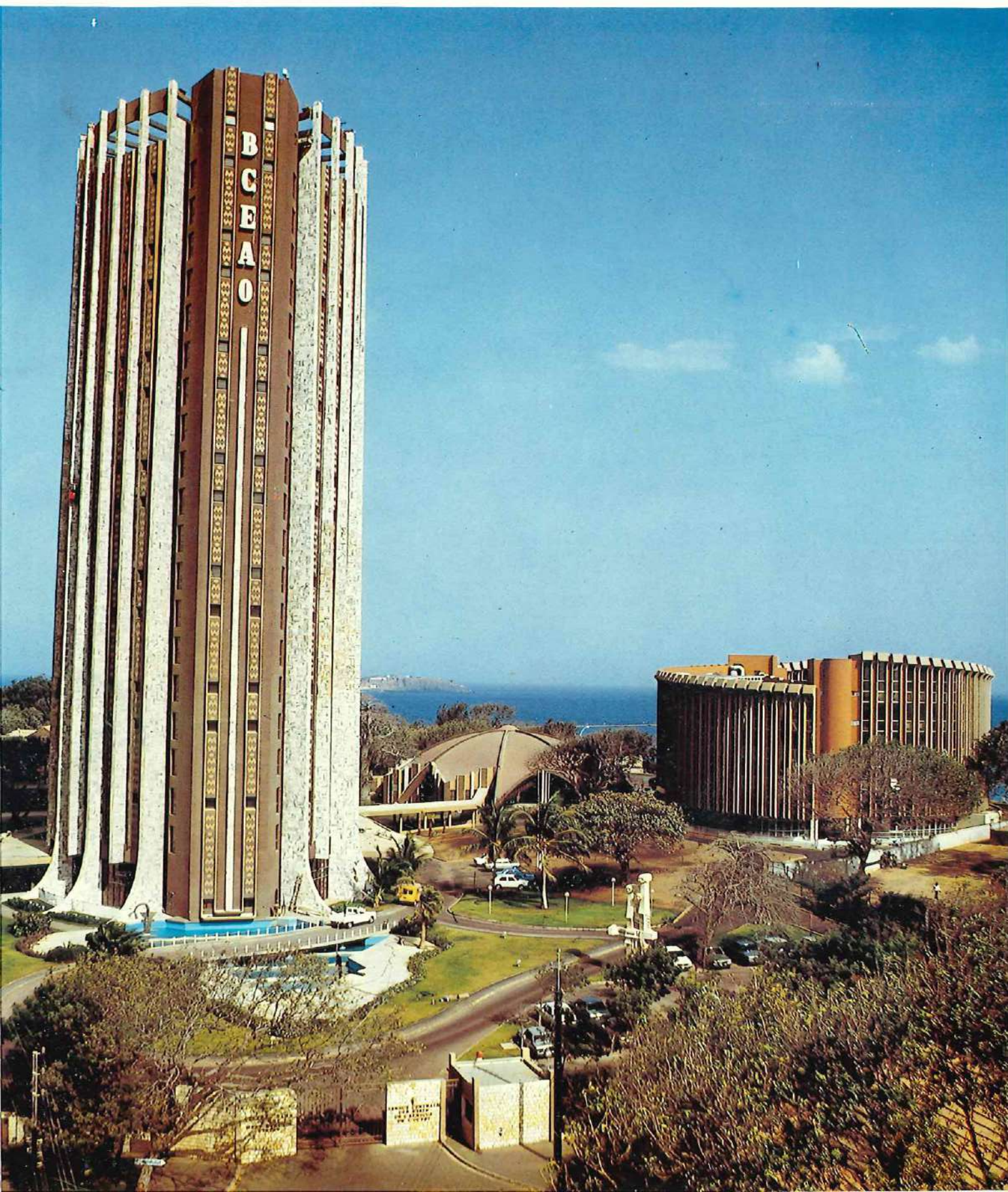
Siège de la Banque centrale à Dakar
