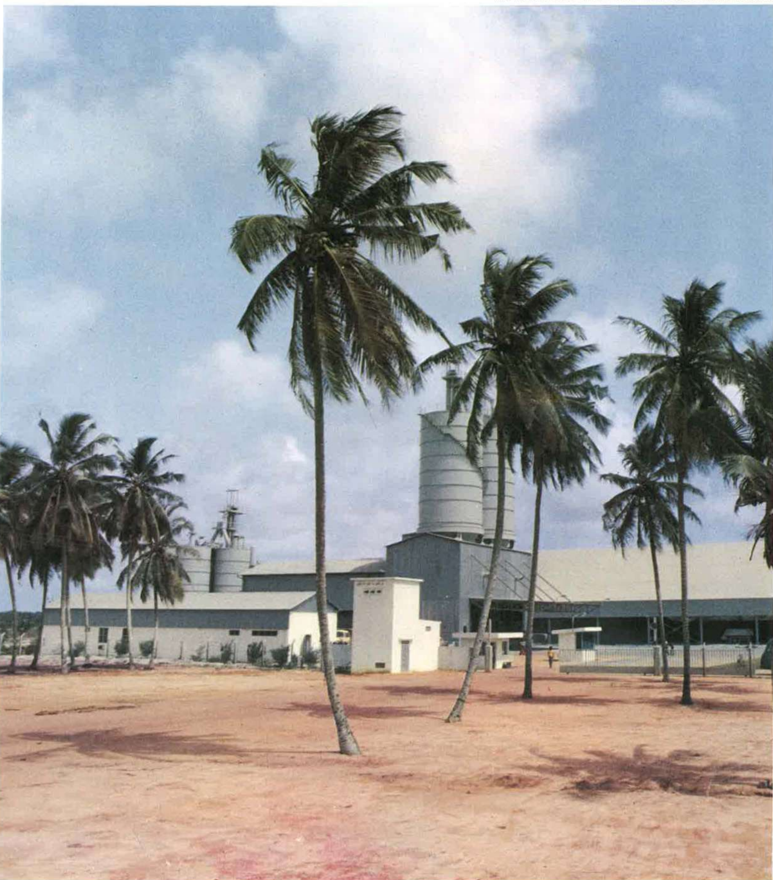
Usine de broyage de clinker de la Société Nationale des Ciments au Bénin
