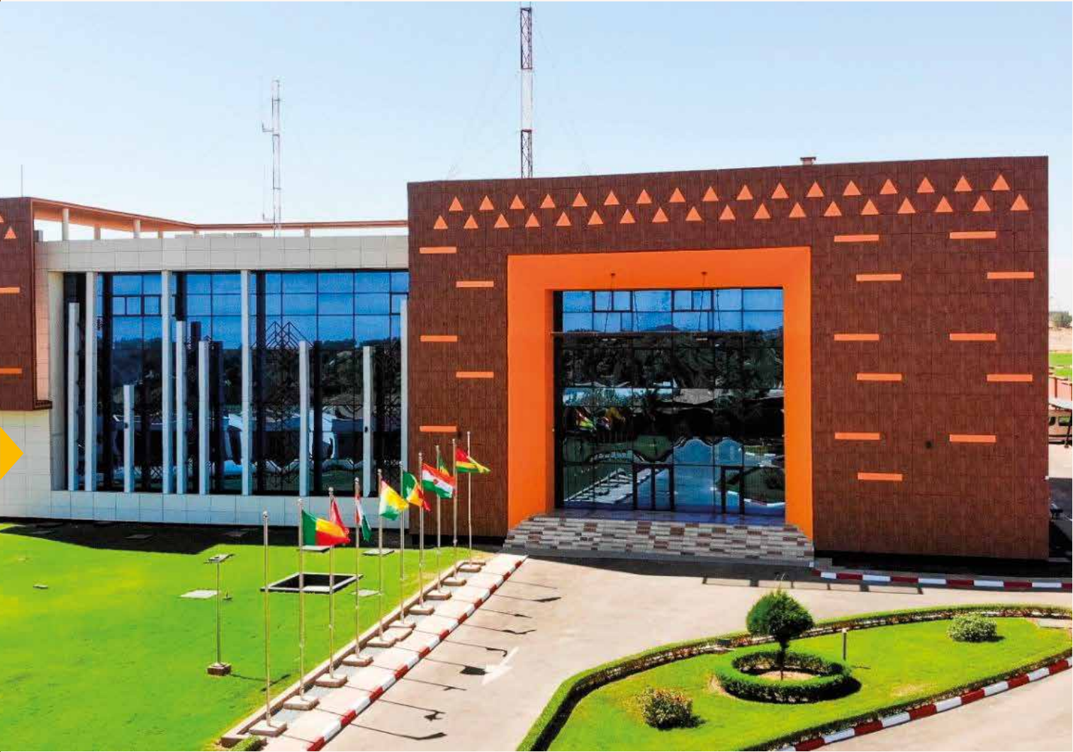
Bâtiment de l'Agence Auxiliaire de Kayes au Mali
