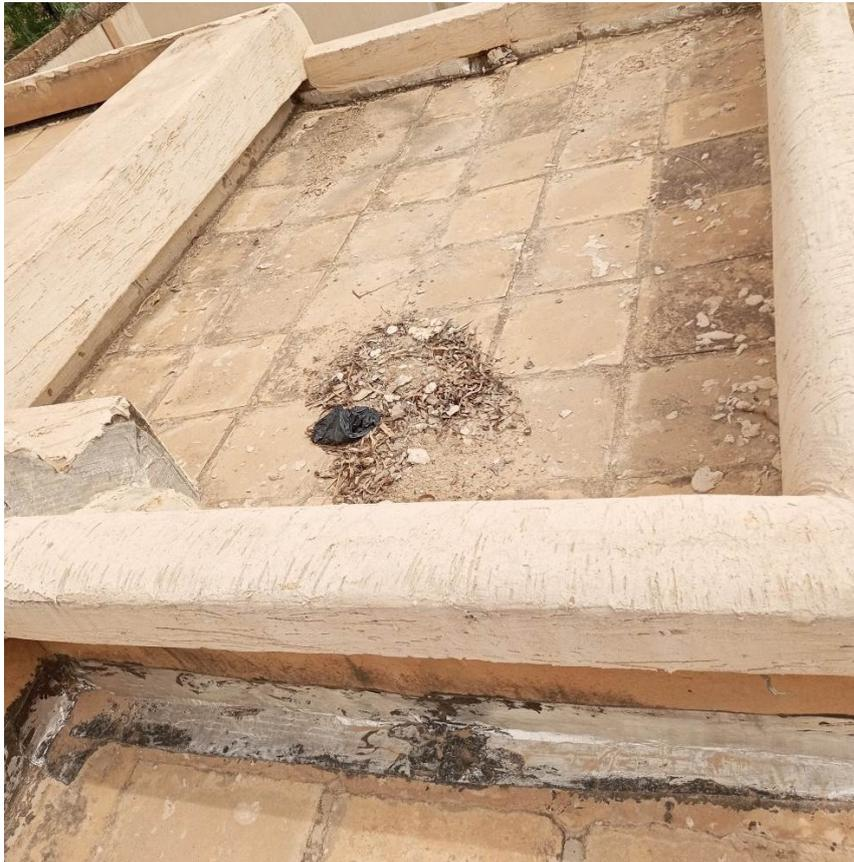
Problème de stagnation d'eaux pluviales et de déchets dû à des mauvaises formes de pente.
