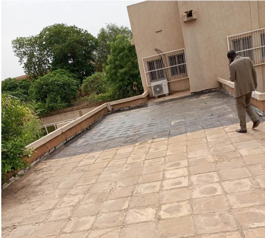
Travaux de colmatage au ciment gris et au bitume pour lutter contre des infiltrations d'eau localisées
