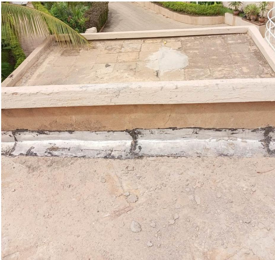
Mauvaise exécution de relevé d'étanchéité
