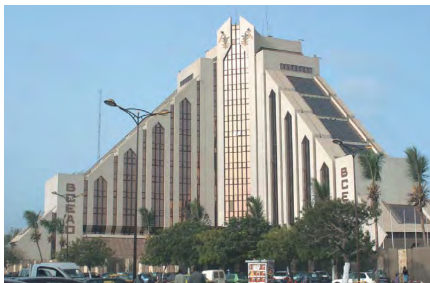
Vue partielle de l'immeuble de l'Agence Principale de la BCEAO à Dakar.
