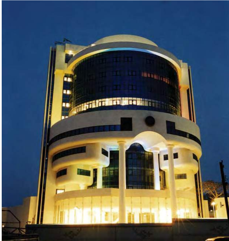
Bâtiment annexe du Siège de la BCEAO.
