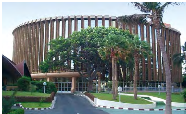
Bâtiment abritant le COFEB au siège de la BCEAO à Dakar.
